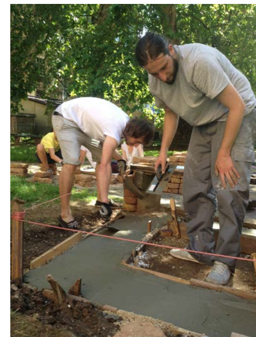
priprema opeke opeka je zahtijevala temeljito čišćenje i pripremu prije ugradnje
