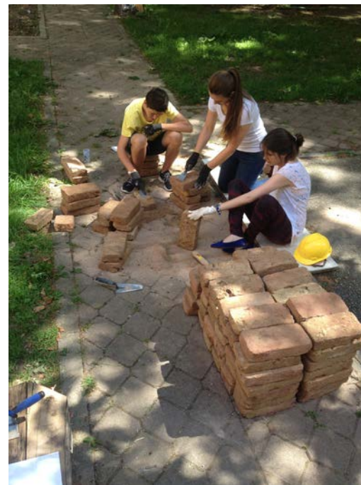
priprema opeke opeka je zahtijevala temeljito čišćenje i pripremu prije ugradnje
