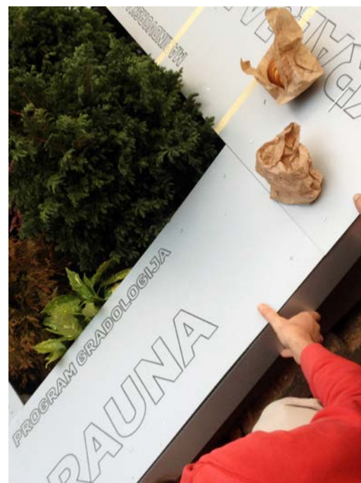
završni radovi – postavljanje alubond ploča sa graviranim natpisima osim učesnika radionice, radovi su obavljani uz pomoć majstora, pa je tako osigurana mnogo veća preciznost u izvođenju
