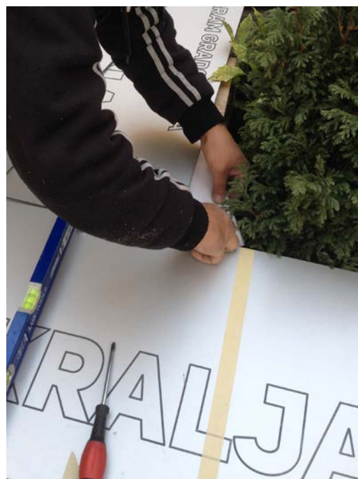
završni radovi – postavljanje alubond ploča sa graviranim natpisima osim učesnika radionice, radovi su obavljani uz pomoć majstora, pa je tako osigurana mnogo veća preciznost u izvođenju
