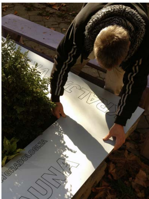
završni radovi – postavljanje alubond ploča sa graviranim natpisima osim učesnika radionice, radovi su obavljani uz pomoć majstora, pa je tako osigurana mnogo veća preciznost u izvođenju
