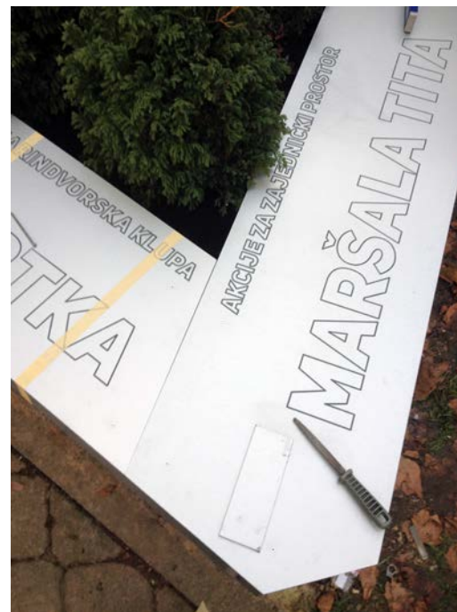
završni radovi – postavljanje alubond ploča sa graviranim natpisima osim učesnika radionice, radovi su obavljani uz pomoć majstora, pa je tako osigurana mnogo veća preciznost u izvođenju
