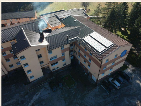
Slika 8.4 Sistem solarnih kolektora na krovu JU Zavoda "Drin" 42
