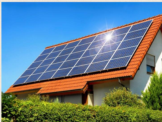
Slika 8.1 Primjena solarnih panela na krovu stambenog objekta 39
