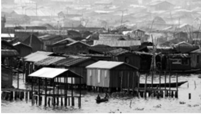
Die Wassersiedlung Makoko in Lagos, Nigeria Photo: Rainer Wozny
